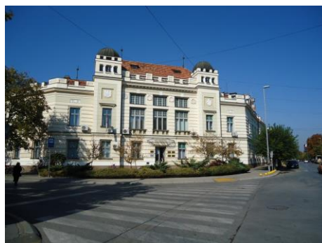
Фотографија бр.1 Зграда општинског суда
