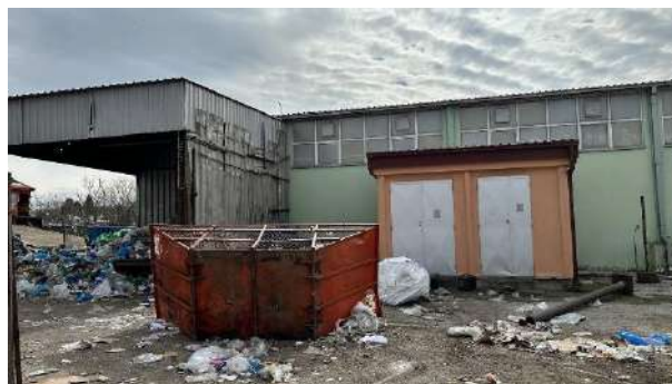
Objekti broj 5 i 7
