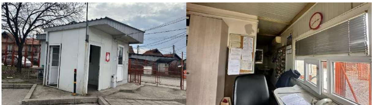
Objekat NN-1 se koristi kao prostor za odlaganje radnih odela i perionica. Objekat je zidan cca 2010. godine i spratnosti je Pr, površine u osnovi 186m 2 . Objekat je izgrađen masivnim sistemom gradnje koristeći AB noseće stubove i AB horizontalne grede dok su fasadni zidovi izgrađeni masivnim sistemom od opekarskih porizvoda. Korisna visina u objektu je od 2,9 do
