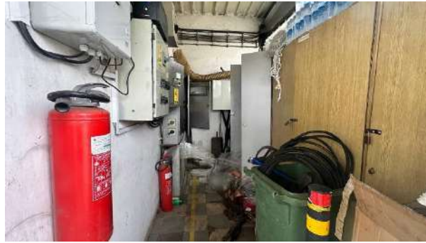
Objekat broj 8 je nadstrešnica koja se naslanja na objekat broj 10.
