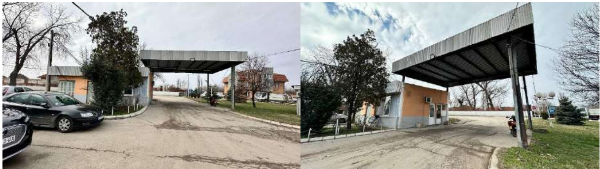
NN-2 Neupisan objekat benzinske stanice. Nadstrešnica i objekat kancelarije.
