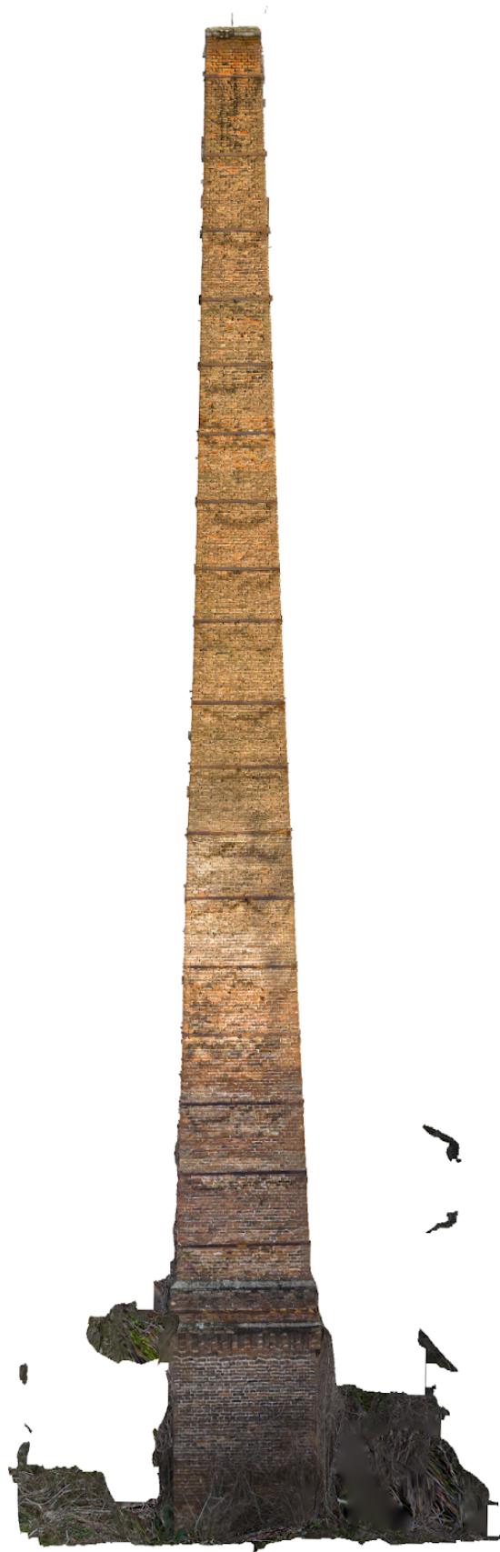
Изглед димњака са западне стране
