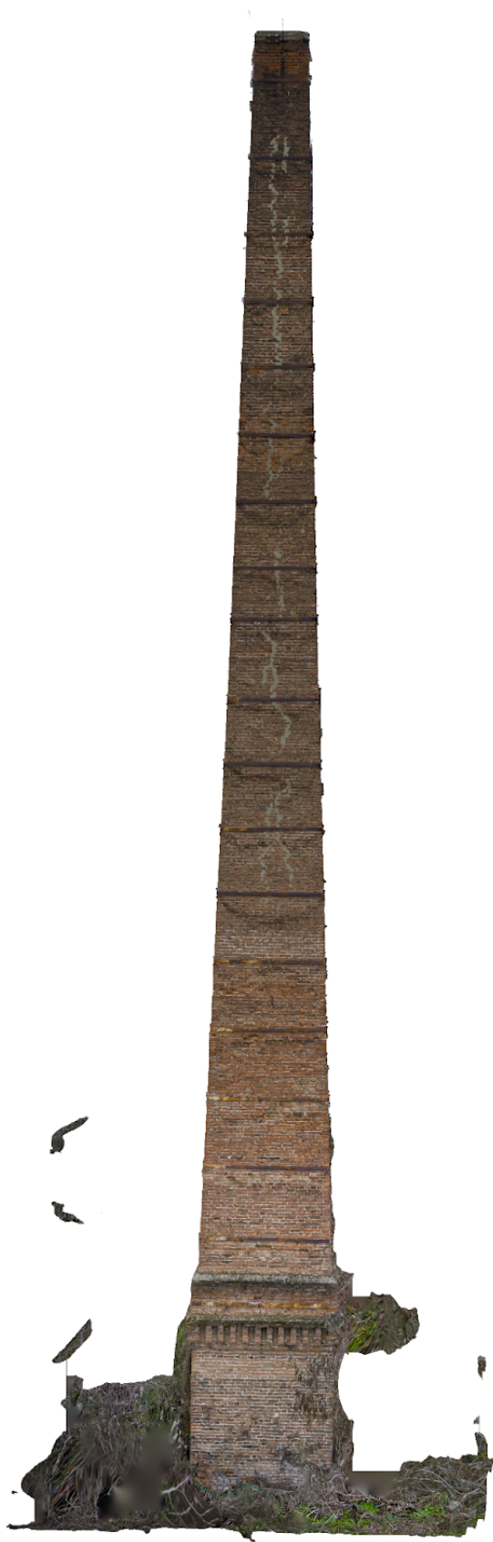
Изглед димњака са источне стране
